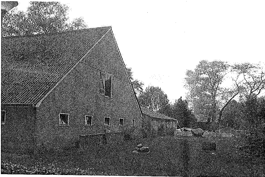
Foto 2: aanzicht vanaf de straat van het hoofdgebouw
