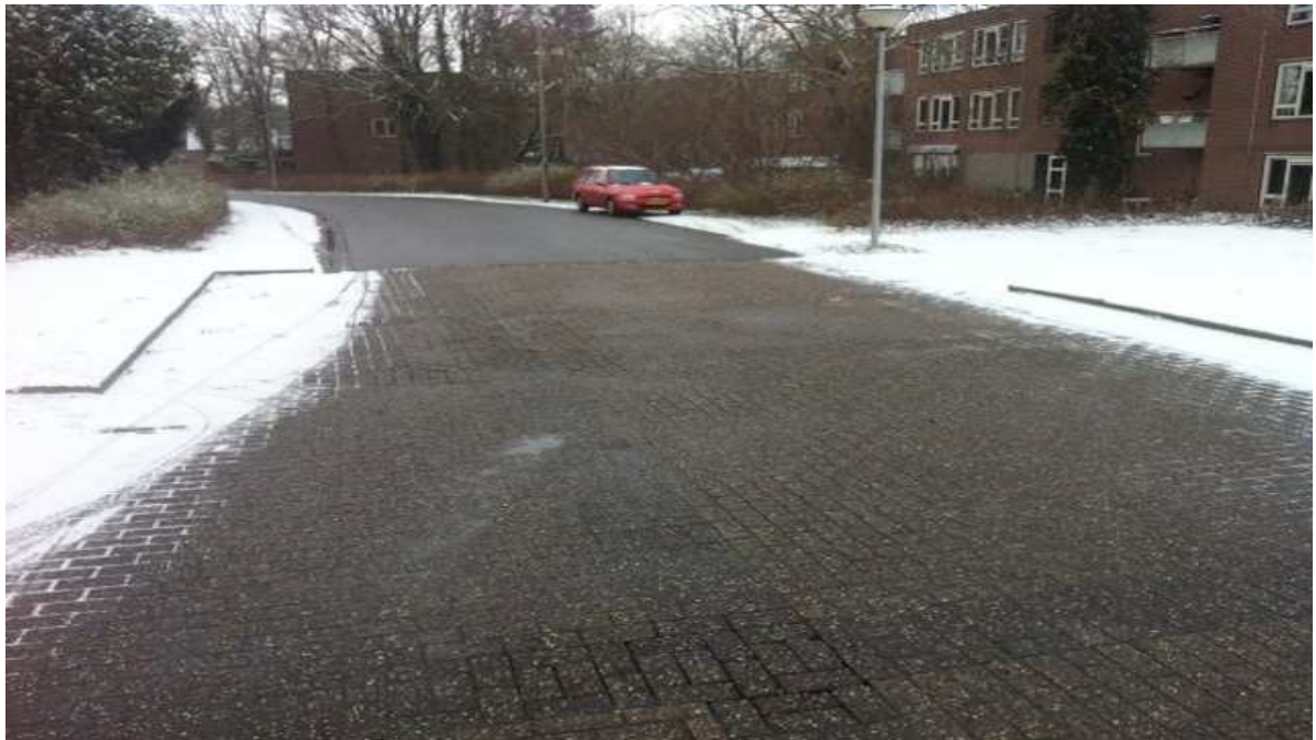
Hoofdrijbaan 2 uur na de actie (overgang asfalt klinkers).
